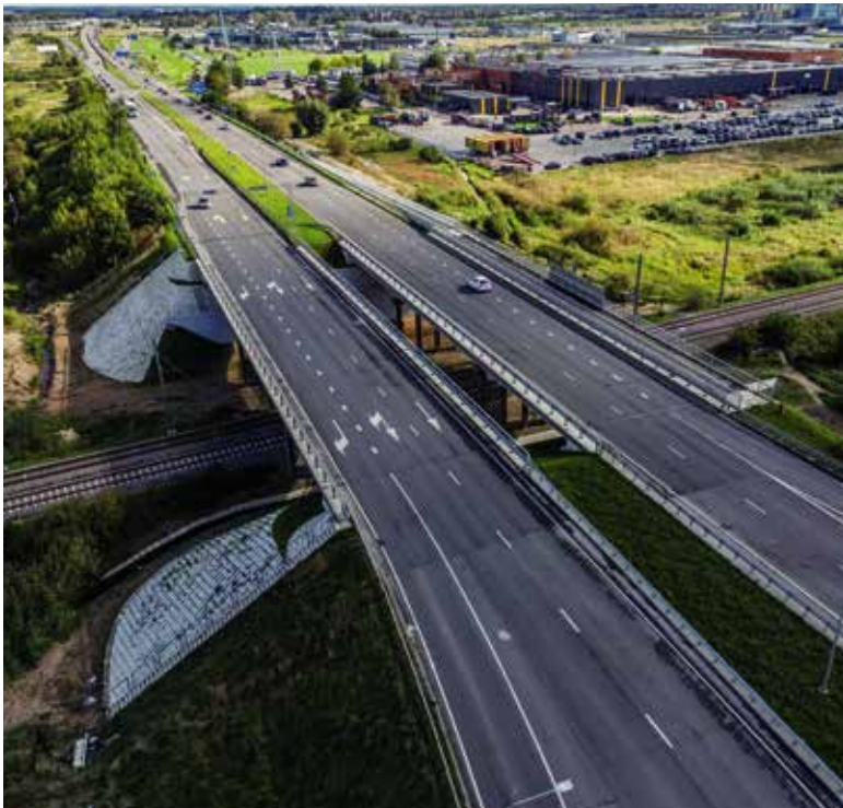
MAĢISTRĀLĀ AUTOCEĻA A1 VIĻŅA-KAUNA - KLAIPĒDA REKONSTRUKCIJAS NODOŠANA EKSPLOATĀCIJĀ LIETUVĀ
