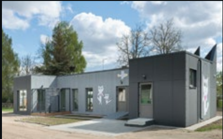
LBTU WMF MAZO DŽĪVNIEKU PATVERSMES MODERNĀS ĒKAS "KAĶU MĀJA" IZBŪVE JELGAVĀ, LATVIJĀ.
