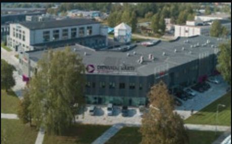
A KLASĒS BIROJU KOMPLEKSA DIENVIDU VĀRTI IZBŪVE RĪGĀ, LATVIJĀ.
