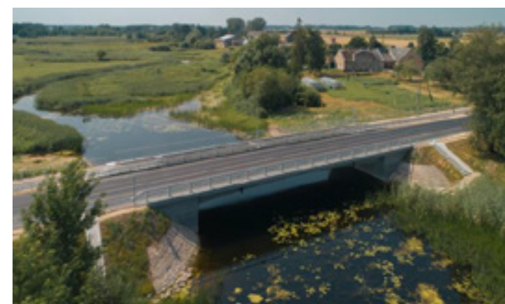
Tilta pār Svētes upi pārbūve uz reģionālā P95 autoceļa Jelgava-Tērvete-Lietuvas robeža (Žagare)
