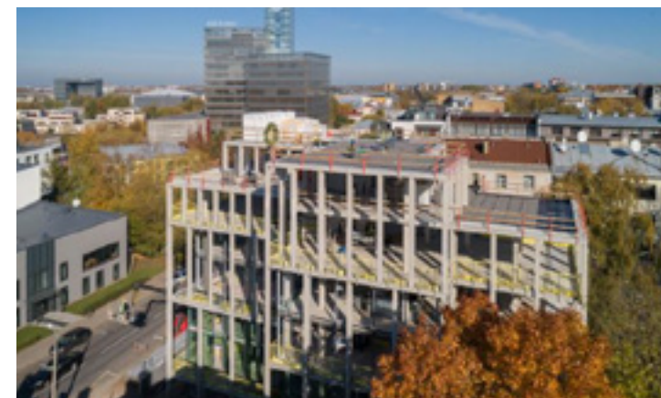
Dzīvojamās ēkas Renaissance izbūve Vesetas ielā 6, Rīgā, Latvija
