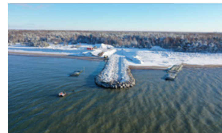
Jūras krasta aizsargbūves (būnas) izbūve, lai novērstu krasta eroziju un aizsargātu notekūdeņu iekārtas Liepājā, latvija
